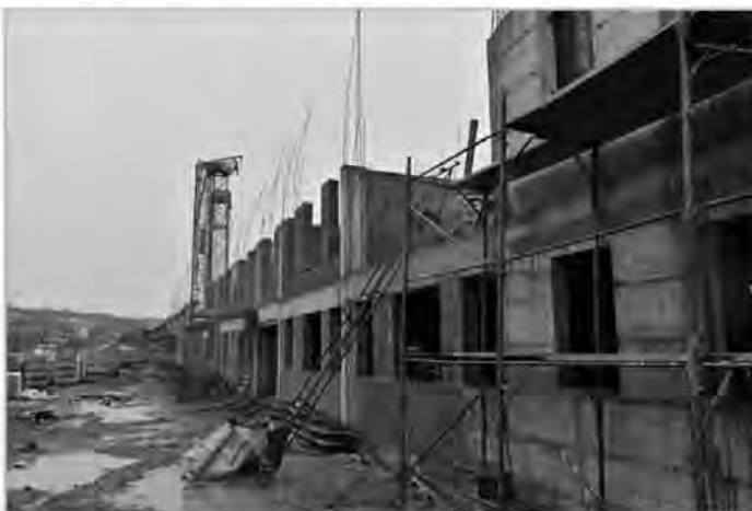
ЗАВРШЕТАК РАДОВА ДО СРЕДИНЕ АВГУСТА: у згради и 15 станова за социјално становање
