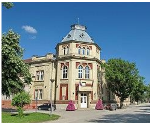
Слика 2: Зграда скупштине општине Велико Градиште
